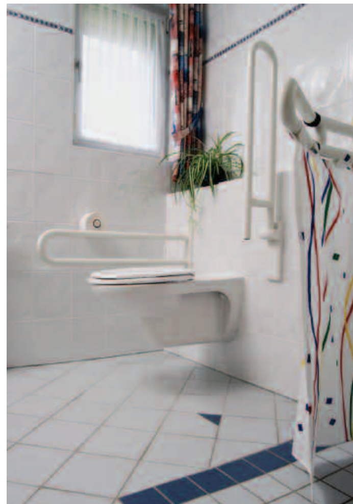
Wandhängendes, leicht erhöhtes WC mit Haltegriffen
